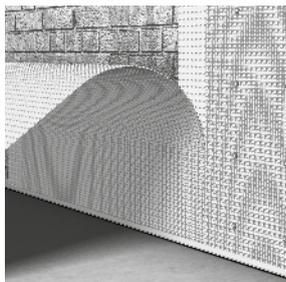
Pose des lés successifs avec 20 cm de recouvrement. Prévoir les percements (prises électriques, conduites...).
