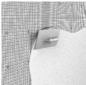
Pose de la finition (enduit, plaque de plâtre, lambris...).
